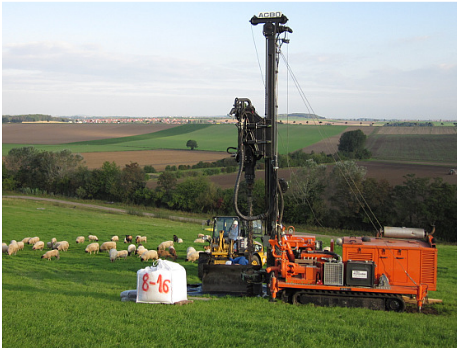
Bohren von Gasbrunnen inkl. Abfallfeststoffprobenahme
